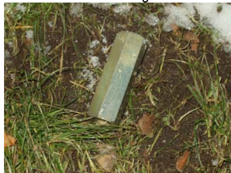
Erkennbarkeit der Ankerstäbe durch Gelbverzinkung (Abb. A / 38)
